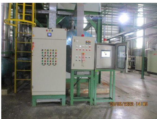
รูปที่ 49 ระบบควบคุมการทำงานหม้อไอน้ำ
