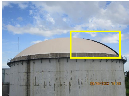
รูปที่ 3 การคลุมบ่อ UASB
