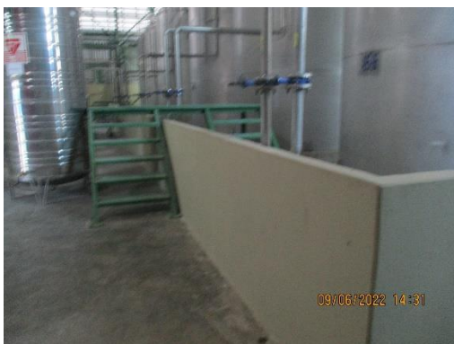
รูปที่ 48 คันคอนกรีตล้อมรอบถังเก็บแอลกอฮอล์
