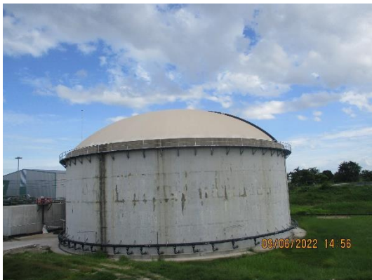
รูปที่ 3 การคลุมบ่อ UASB
