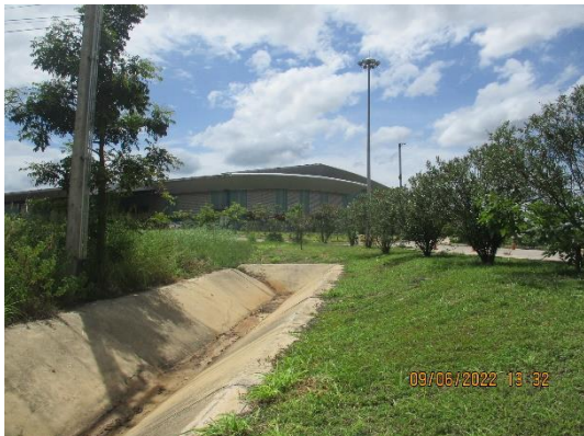
รูปที่ 14 รางระบายน้ำชนิด คสล. รูปสี่เหลี่ยมคางหมู
