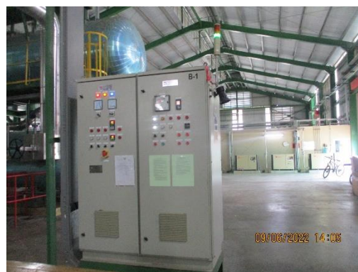
รูปที่ 49 ระบบควบคุมการทำงานหม้อไอน้ำ
