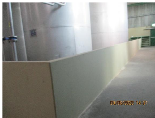
รูปที่ 48 คันคอนกรีตล้อมรอบถังเก็บแอลกอฮอล์
