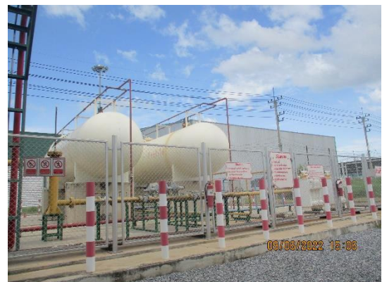
รูปที่ 53 พื้นที่จัดเก็บก๊าซปิโตรเลียมเหลว (LPG)
