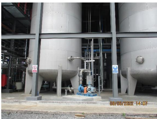
รูปที่ 47 ถังเก็บและเครื่องสูบลูกบอลแอลกอฮอล์
