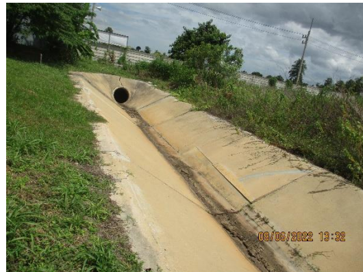
รูปที่ 14 รางระบายน้ำชนิด คสล. รูปสี่เหลี่ยมคางหมู
